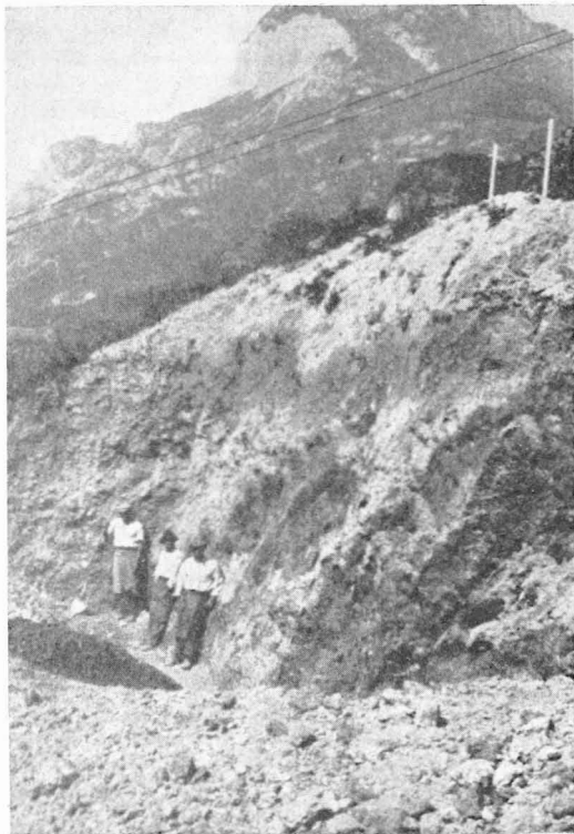
Fig. 2 - Dornach: profondi scassi nella « mittlere Steingleite » durante i lavori 1929-1931. Fotografia da Sud.
